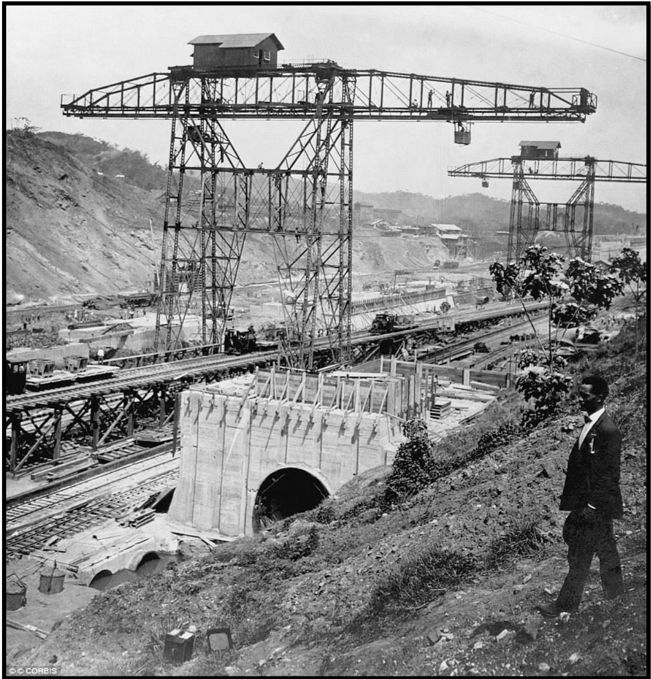
CONSTRUCCIÓN DE LAS ESCLUSAS EN EL PACIFICO. NOTEN LAS DOS PERSONAS EN LA "GRUA T" PACIFIC SIDE LOCKS CONSTRUCTION, NOTICE THE TWO PERSONS UP ON THE "T CRANE"
