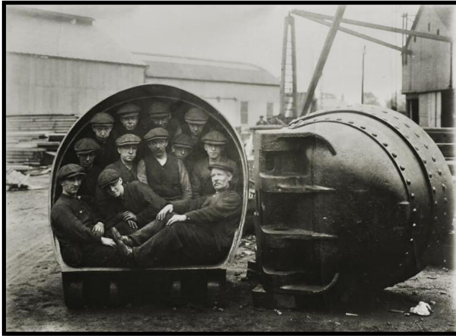
CUCHARON DE LA DRAGA COROZAL CAPACIDAD DE 54 PIES CUBICO – SE PODIAN COLOCAR 12 PERSONAS PARA PODER APRECIAR SU CAPACIDAD DREDGE COROZAL BUCKET CAPACITY 54 CUBIC FEET – TO SHOW ITS CAPACITY IT HAD ROOM FOR 12 PERSONS
