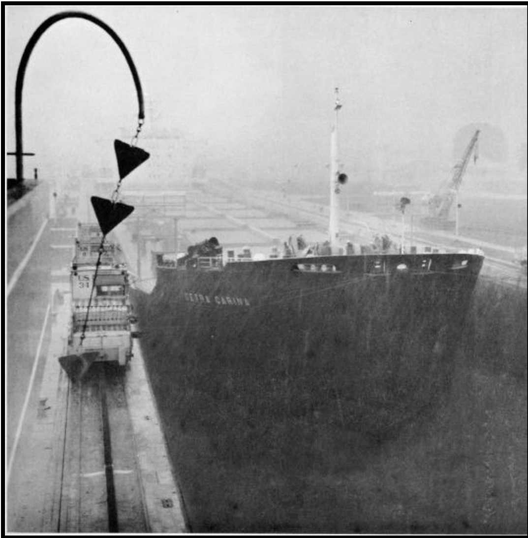
CONOS DE METAL INDICABAN LA CANTIDAD DE PARES DE LOCOMOTORAS UTILIZADAS EN EL ESCLUSAJE, UNA PRÁCTICA YA EN DESUSO METAL CONES INDICATED THE NUMBER OF PAIRS OF LOCOMOTIVES REQUIRED IN A LOCKAGE, AN OPERATION NO LONGER IN USE
