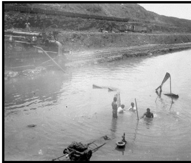
CORTE CULEBRA: INUNDACIÓN POR LLUVIA, BOMBAS DE AGUA TRABAJANDO 1911 CULEBRA CUT: FLOODING AFTER HEAVY RAIN, PUMPS AT WORK 1911
