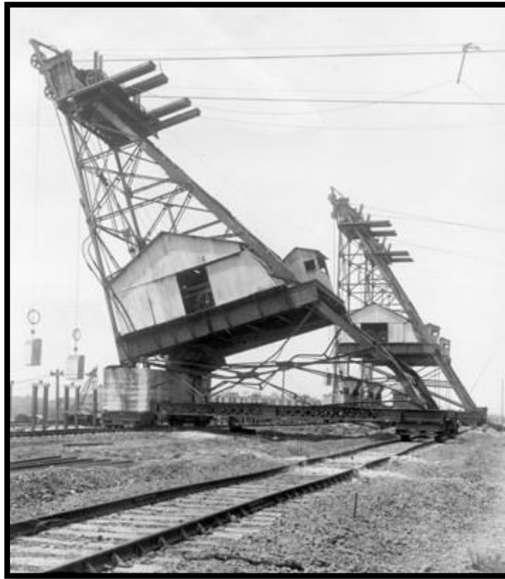
ESCLUSAS DE GATÚN: FALLA DE TORRE 1919 GATUN LOCKS: FAILURE OF HEAD TOWER 1919
